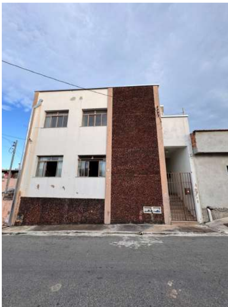
Registro 01: Fachada principal.
