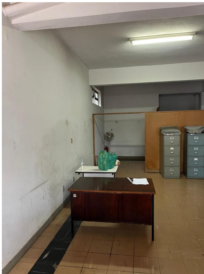
Registro 4: Pintura das paredes internas e teto.
