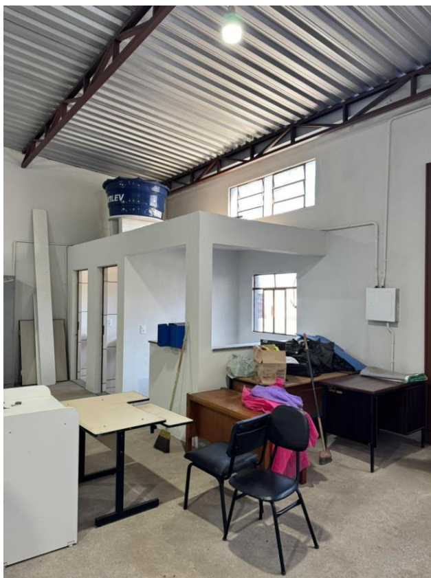
Registro 3: Telha galvanizada e tesouras metálicas.
