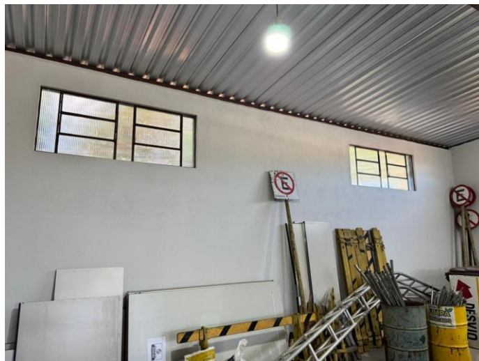
Registro 05: Pintura das paredes internas.
