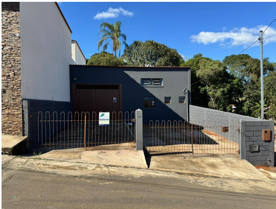
Registro 07: Fachada do galpão.
