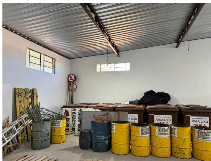
Registro 4: Pintura das paredes internas.
