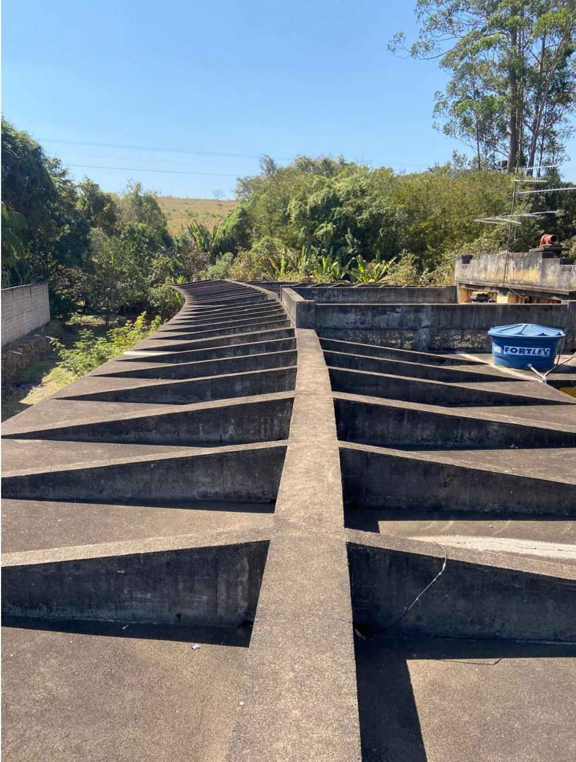
Fotografia 01: Laje/vigas invertidas.
