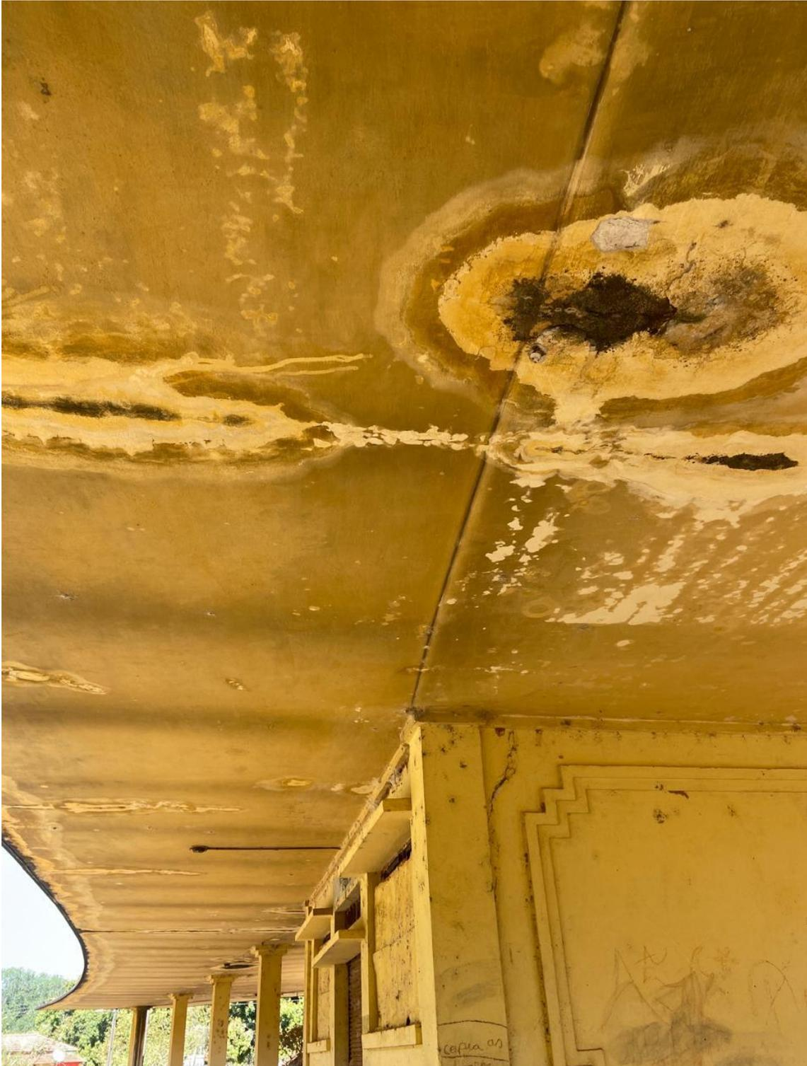
Fotografia 04: Patologias na laje devido infiltração.
