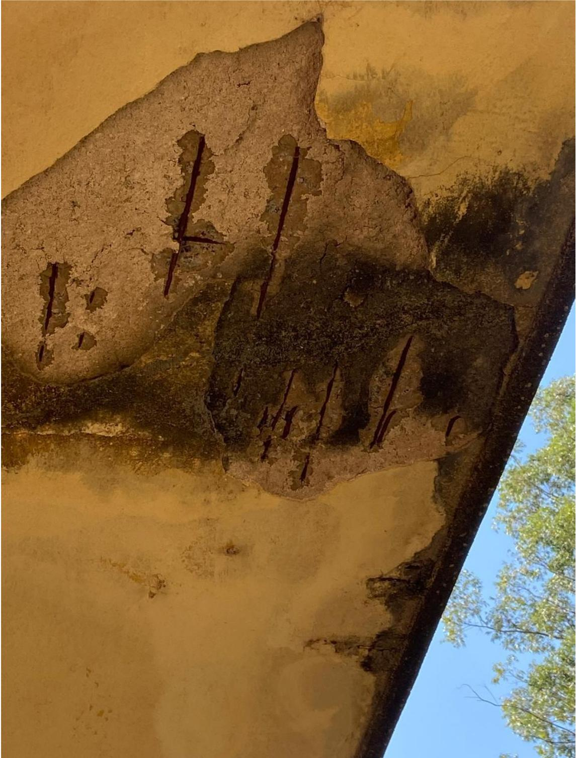
Fotografia 03: Patologias na laje devido infiltração.
